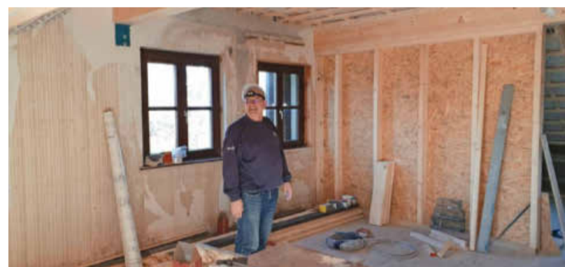
Vereinsmitglied und Monteur Georg Kress im Dachstuhl des Hauses. Hier entsteht eine Pächterwohnung als Rückzugsort. Fotos: Linda Möllers
